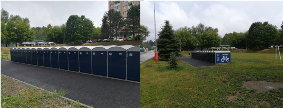
Obr. 41 Pohľad na realizáciu parkovacích boxov pre bicykle v Dolnom Kubíne
