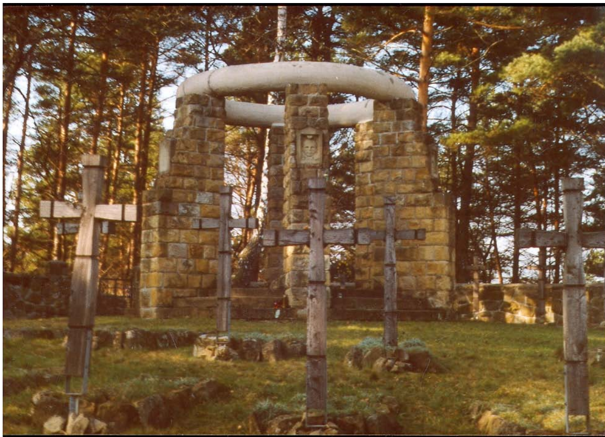
Krempna, element centralny cmentarza nr 6 przed umieszczeniem liści dębowych na wieńcu (fot. A. Piecuch)
