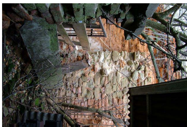
Beth ha midraš, staršia hmota kamenného múru adaptovaná do južnej steny budovy.
