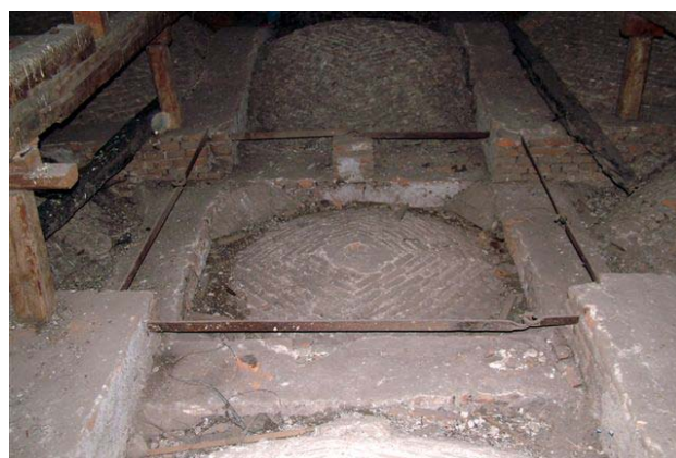
Synagóga, podkrovie, pohľad na kupolu bímy, s kovovými tiahlami.
