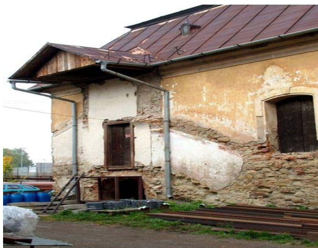
Synagóga, pohľad na južnú fasádu, stopy po prístavbe vstupu a schodiska.
