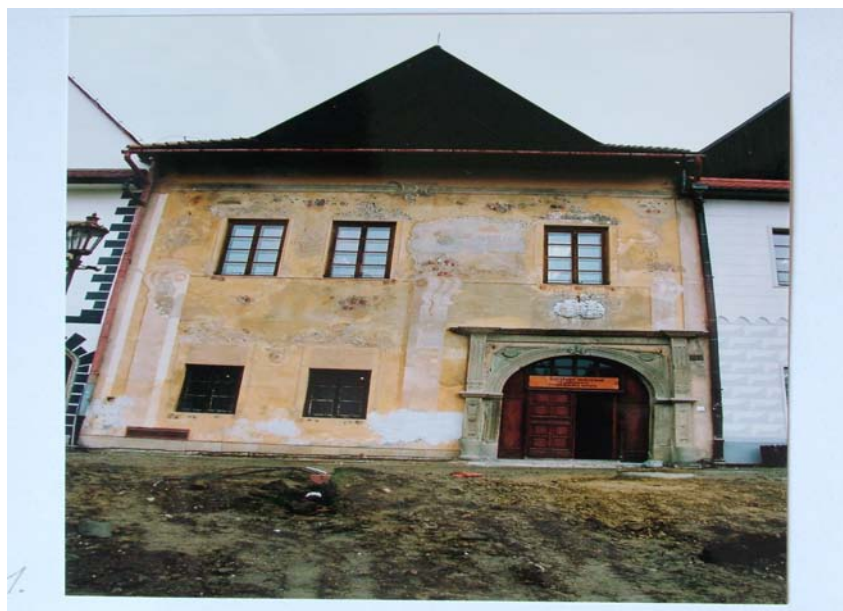
Stav pred reštaurovaním fasády
