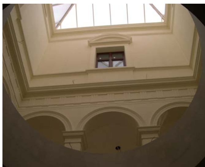
Obr.č.9- átrium – horná časť po obnove
