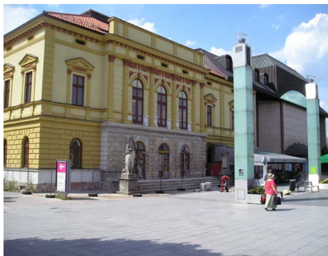
Obr.č.12- východná fasáda s asanovaným portikom
