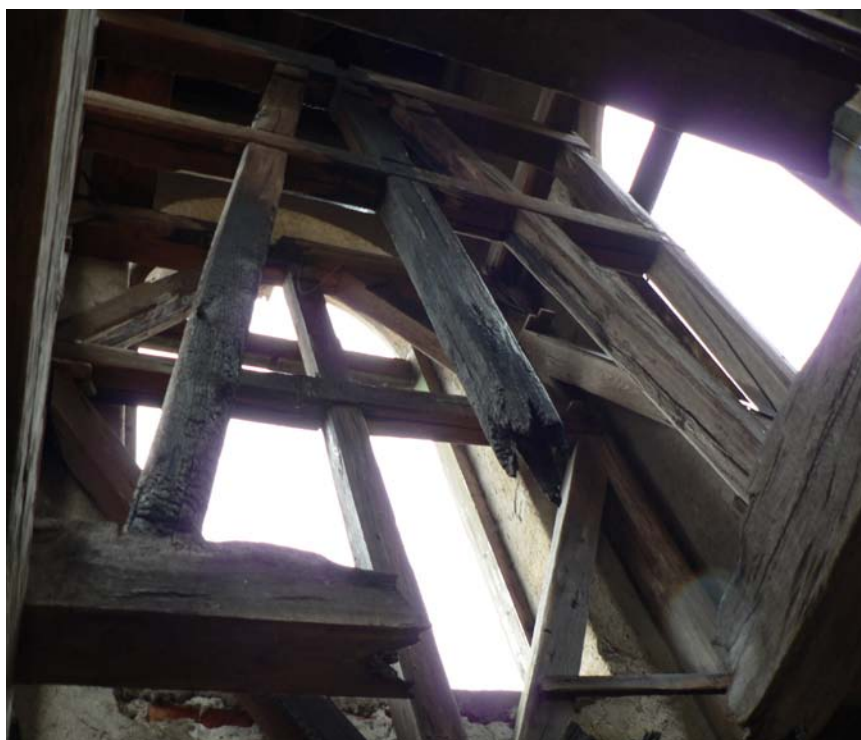
Poškodenie krovu zvonice
