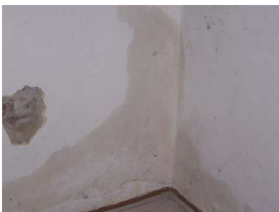
Prejavy kapilárne vztlínajúcej vlhkosti v murive.
