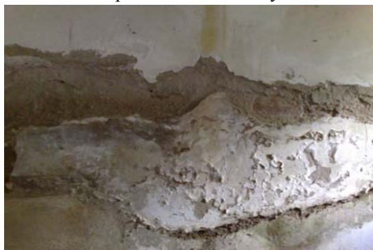
Vlhkosťou a soľami zničené murivo.
