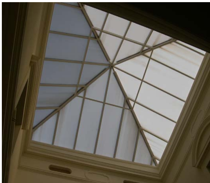
Obr.č.10- svetlák átria po obnove
