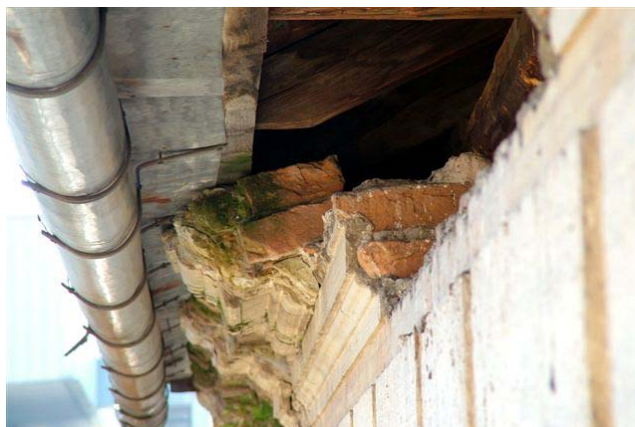
Beth ha midraš, uvoľnená hmota korunnej rímsy na severovýchodnom nároží.
