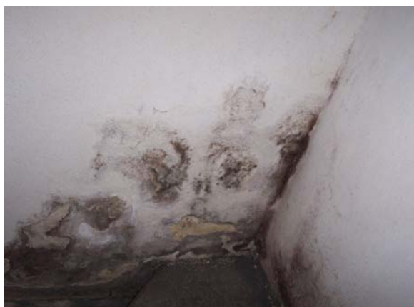
Prejavy kapilárne vztlínajúcej vlhkosti v murive.
