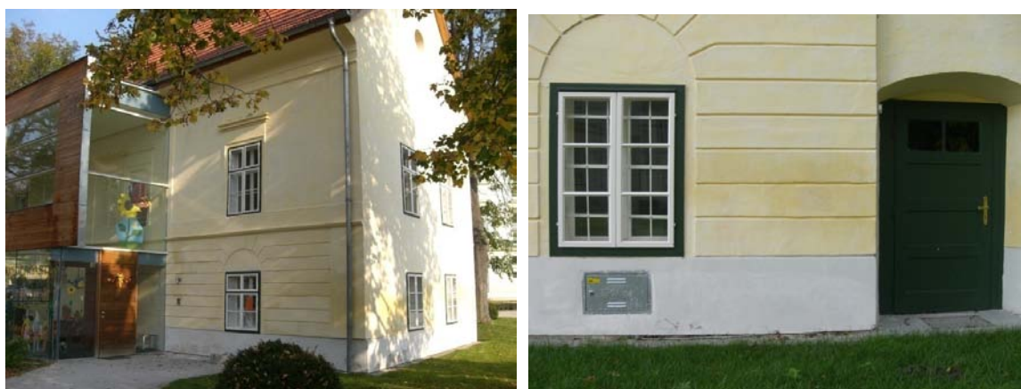
Objekt nebol vysušený, bola použitá len sanácia v r. 2000, čím vznikli zbytočné výdavky.
