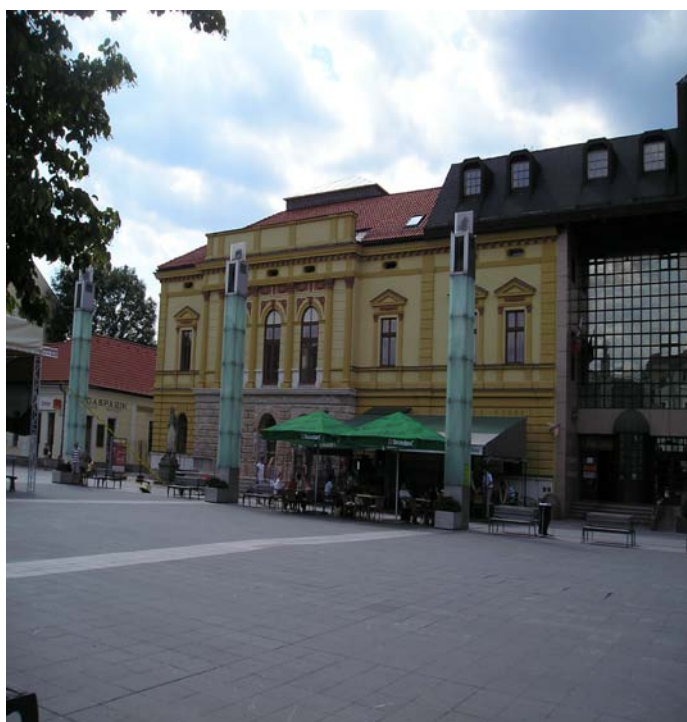
Obr.č.11- východná fasáda zo severného smeru
