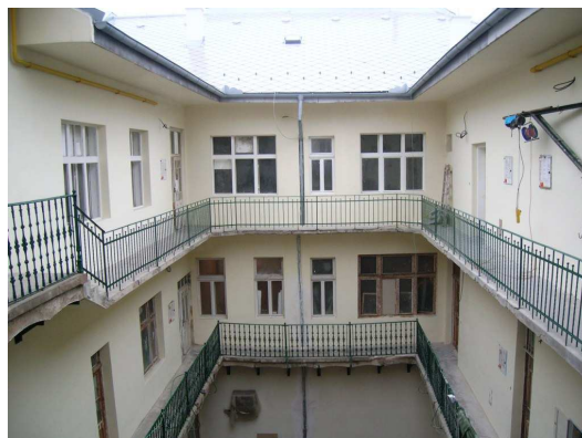
11. dvor domu po obnove).
