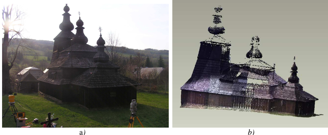
Obr. 1: a) Cerkev Pokrov Presvjatoj Bohorodici počas zamerania pred rekonštrukciou b) naskenované mračno bodov cerkvi.
