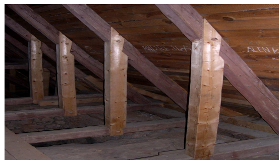
10. Stříbro-Doubrava (ČR), zaniknutá obec, r.kat. kostol sv. Petra – krov nad loďou (1424d) – výmena poškodených pätných vzpier
