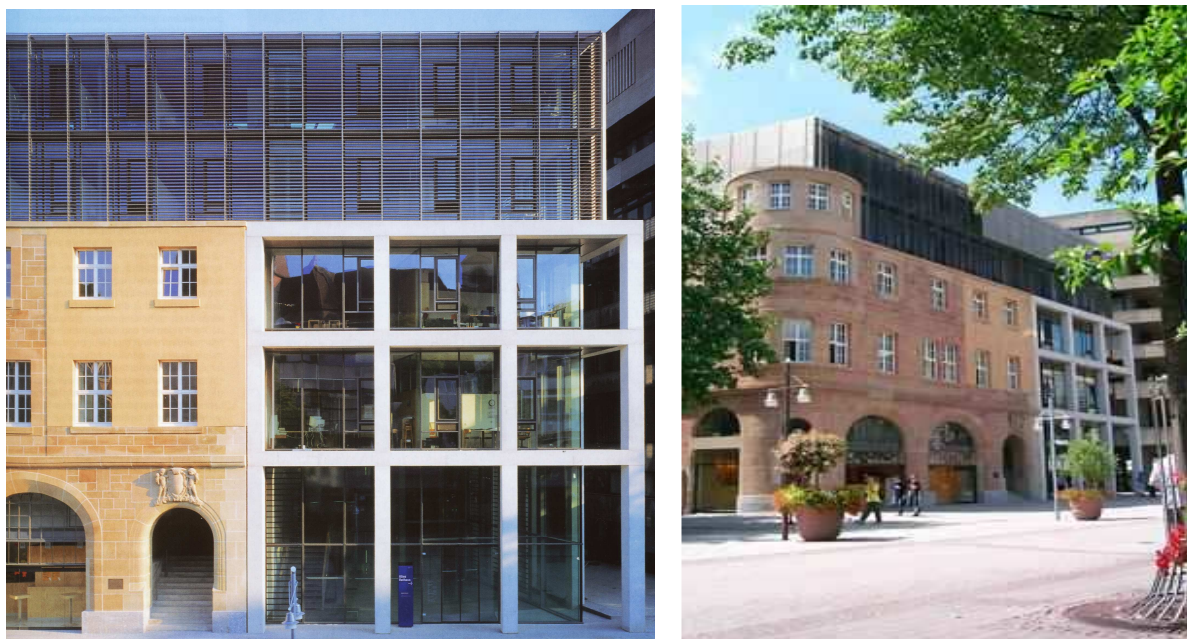
Obr. 1, 2 Auer + Weber + Partner: Dostavba radnice v Pforzheime – použitie typizovanej stĺpkovo-priečnikovej konštrukcie na transparentnej fasáde dostavby s priznaním rámov
