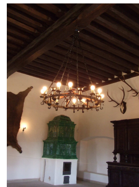
Obr. Pec v skanzene Lipt. dediny v Pribyline. Stav po dokončení. Vrchný ozdobný dielec bude vyhotovený ako hypotetický kus. Zo snímky badateľná proporcia pece a miestnosti.
