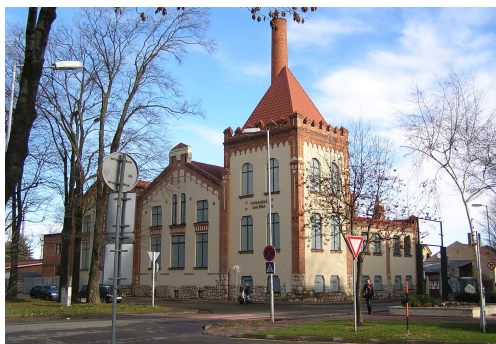
Poprad_elektrárň_v priebežnej úprave
