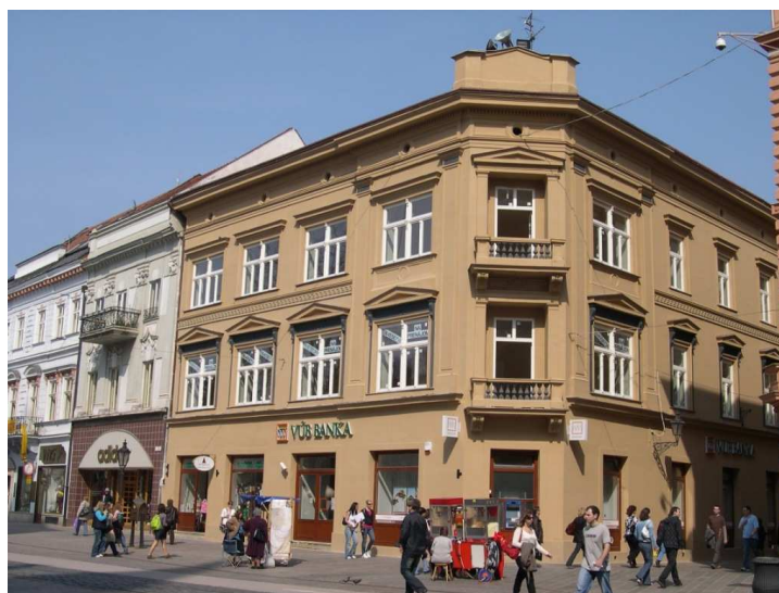
(obr. 8 pohľad na nárožný dom).
