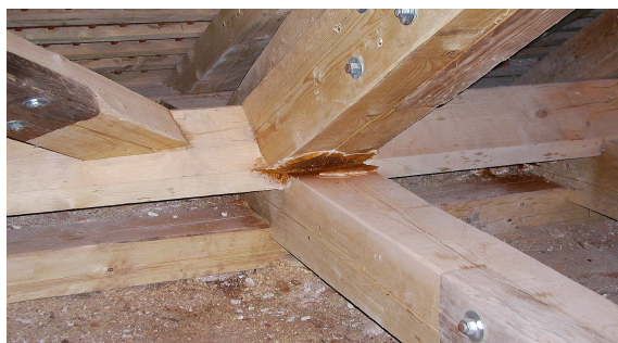
9. Pernštejn, hrad (ČR), krov z 18. st. nad palácom – protězy stiahnuté svorníkmi, krátko po obnove na novej konštrukcii drevokazná huba - drevomorka domáca
