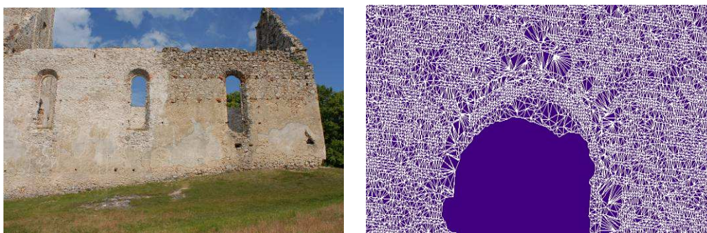
Obr. 10 Pôvodná snímka (vľavo) a detail TIN modelu (vpravo)
