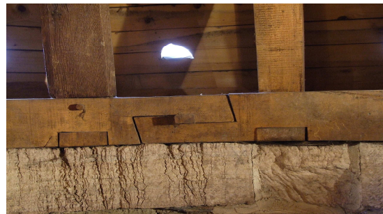
8. Freistroff (Francúzsko), obnova krovu na zámku – napojenie novej pomurnice rovným hakovým plátom
