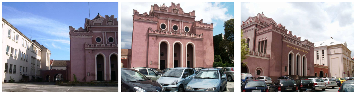
(obr. 14 dvor školy a ortodoxnej synagógy pred obnovou obr. 15. dvor novo využívaný na parkovanie obr. 16. uličná fasáda synagógy)
