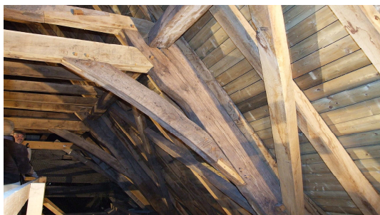
7. Freistroff (Francúzsko), obnova krovu na zámku – s klinom, so šikmo zrezanými čelami šikmé hákové plátovanie hambáľku s „hmoždíkmi“, plombovanie pásika a výmena rozpery
