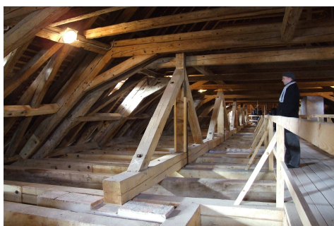
11. Kostelec nad Černými lesy (ČR), krov s ležatými stolicami na zámku – vyvesenie stropov vešadlovou konštrukciou
