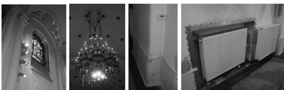
**Obr.10:** 10a) Vhodné umiestnenie reflektorov pri víťaznom oblúku, 10b) modernizácia lustra doplnenými novými reflektormi, 10c) Termostat pre vykurovanie na bočnej stene lode, 10d) Vykurovacie telesá narúšajúce estetickú jednotu interiéru. zdroj 10a-10b-10c-10d: fotoarchív Kristína Kalašová, 07/2015
