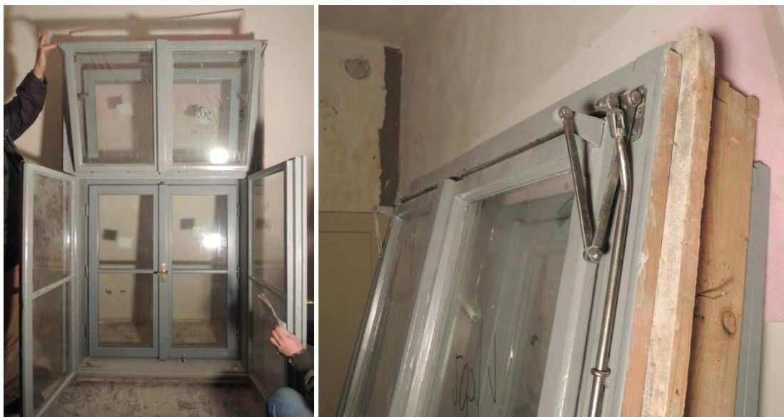
**Obr. 6:** Drevené okno s repasovanými vnútornými krídlami a skriňovou konštrukciou, vonkajšie krídla sú kópie pôvodných s namontovaním očistených pôvodných kovaní, sfunkčnený pákový otvárací mechanizmus Zeus.
