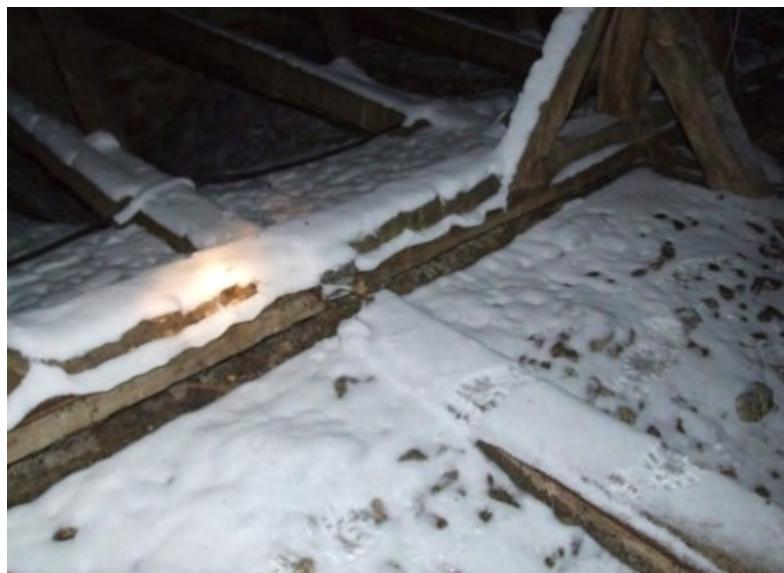
**Obr. 7:** Vrstva snehu v priestore krovu na r.k. kostole v Matiašovciach ako dôsledok výrazne zdegradovanej krytiny (drevený šindel). autor : Krušinský, P.
