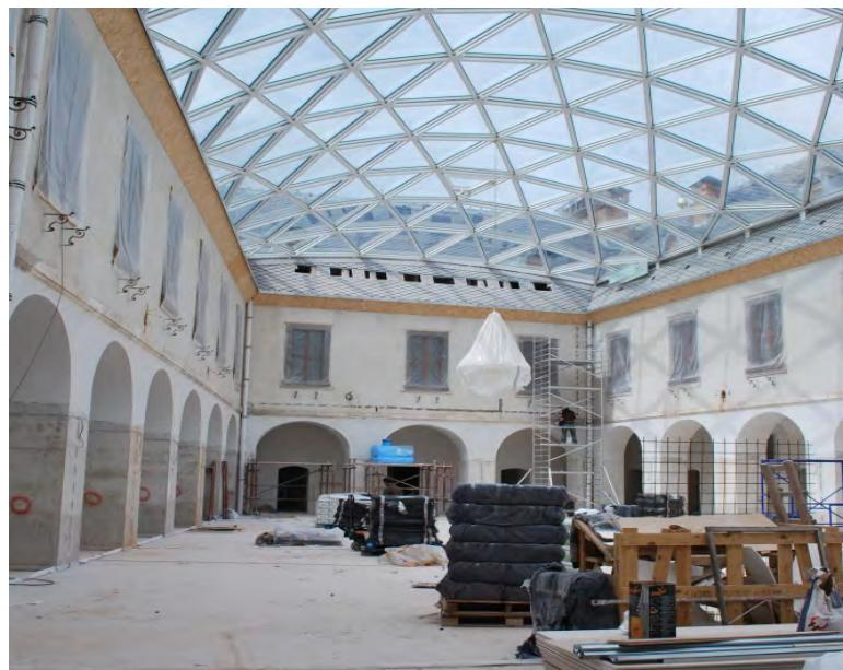
**Obr.9:** Realizácia presklenia nádvoria s pohľadom na umiestnenie vzduchotechniky, r. 2013,
