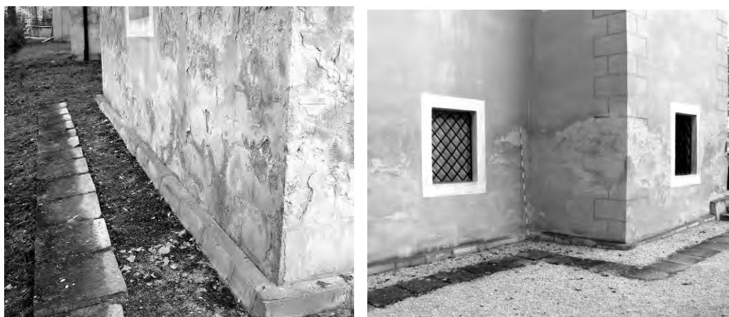
**Obr.5:** Kaštieľ v Brodzanoch. Vľavo: Zásyp výkopu drenáže triedeným štrkcom spôsobuje koncentráciu povrhovej a podpovrhovej vody v kontakte objektu s terénom. Neodvetraná vzduchová vrstva vytvorená vlnitými doskami z AZC je nevhodná a nevytvára bariéru proti infiltrácii vody do muriva. Murivo nemá na základovej časti zvislú ani vodorovnú izoláciu proti vode a vlhkosti. Foto: J. Babjak, 2014.
