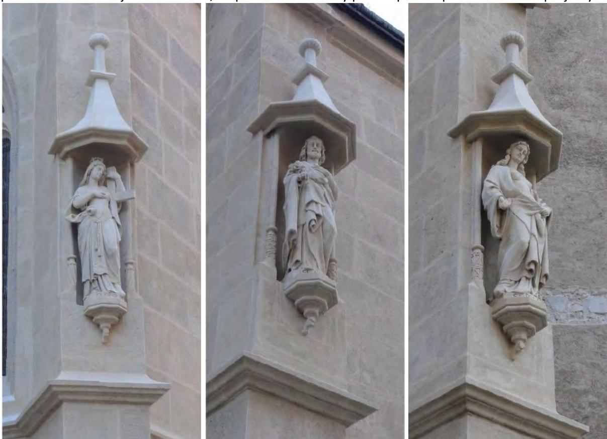
**Obr. 10:** Výsledok po realizácii a osadení fiál na kaplnke sv. Anny (Zdroj foto: V. Hain, M. Ganobjak, 2012)
