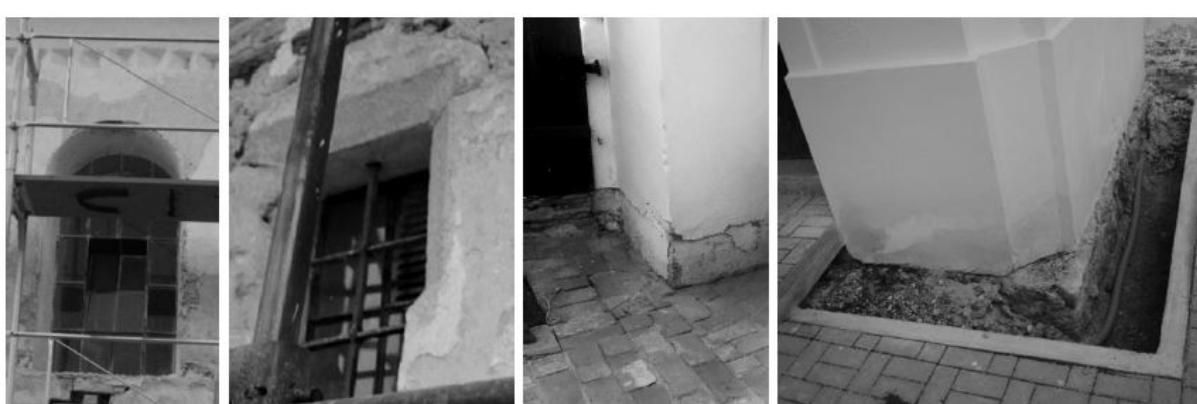
**Obr.2:** 2a) Otváracá časť okna v lodi, 2b) Okno s trvalým prevetrvávaním mriežkou, 2c) rozoberateľná tehlová podlaha, 2d) vonkajšia sanácia vlhkosti s vloženým elektrokáblom.
