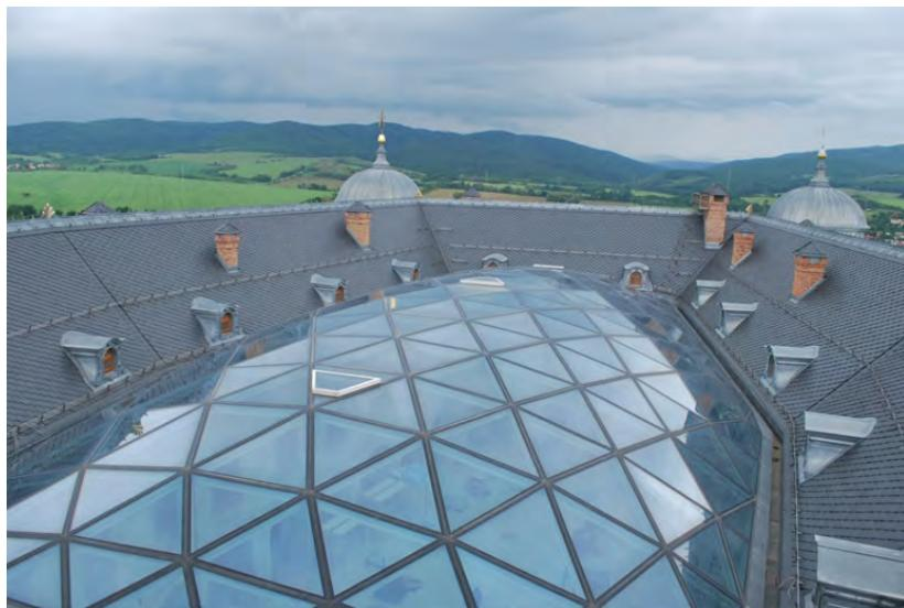
**Obr.6:** Detail segmentového presklenia, rešpektujúceho nerovnú úroveň korunných ríms, r. 2014,
