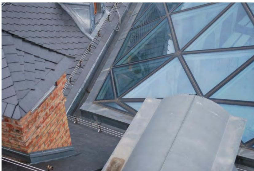
**Obr.7:** Detail okapového žľabu a časti trojuholníkových dielov presklenia, foto vlastníka NKP
