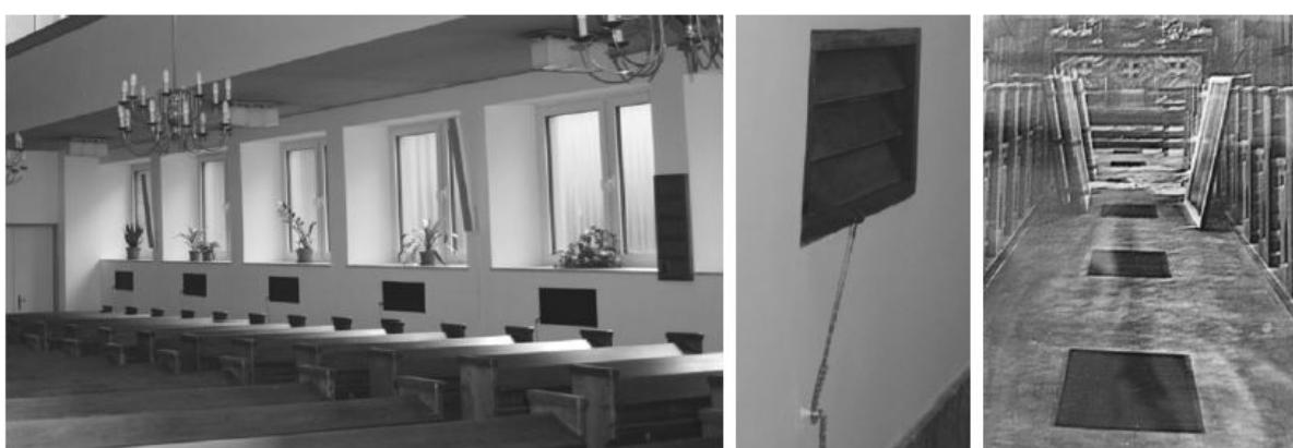
**Obr.6:** 6a) Teplovzdušný kanál zabudovaný v stene, 6b) Prevetrvácia žalúzia s ovládaním
