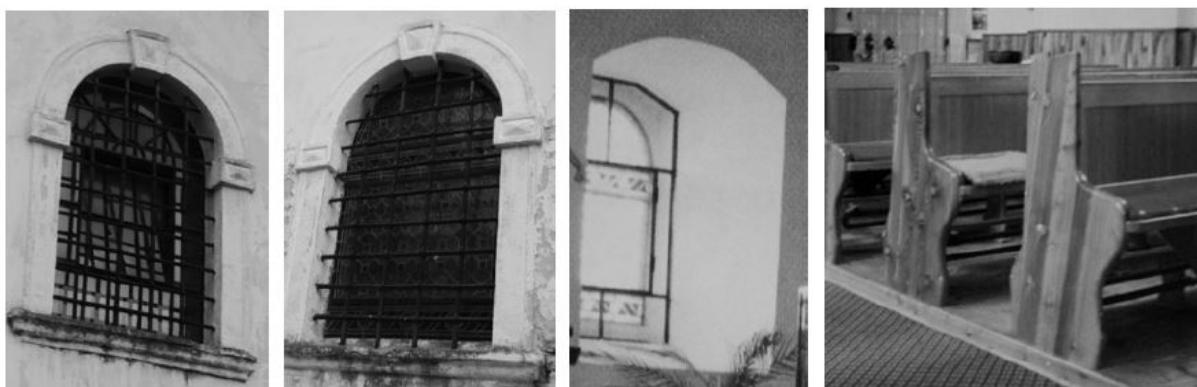
**Obr.4:** 4a) Vyklápacia časť okna v lodi, 4b-c) Okno presbytéria - vitráž a sekundárne interiérové okno s otváraním, 4d) Vykurovacie trubky UK pod sedákmi lavice.
