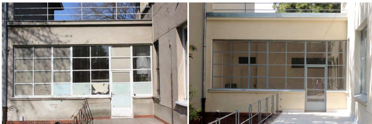
**Obr. 4:** Presklená stena spojovacej chodby pred a po reštaurovaní.
