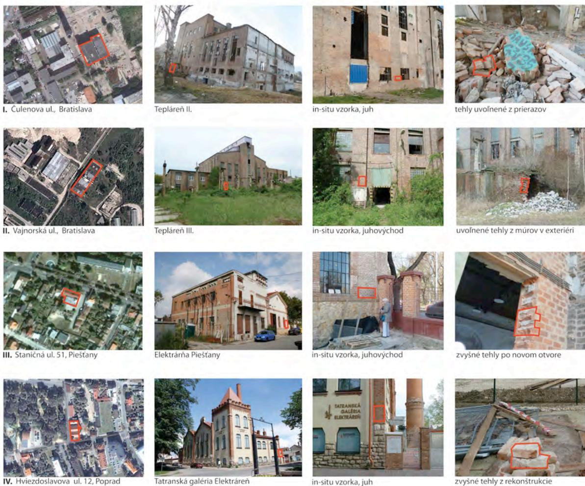
**Obr. 2:** Presné umiestnenie vzoriek in-situ na overovacích štúdiách I. až IV. a zdroj získaných tehel pre laboratórne experimenty.
