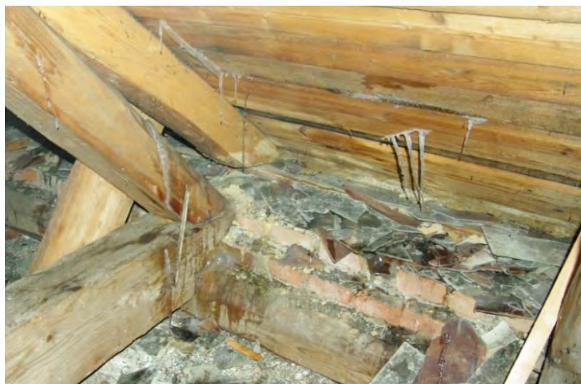
**Obr.10:** Zatekanie v krove na evanjelickom kostole vo Vyšnej Boci v zimnom období
