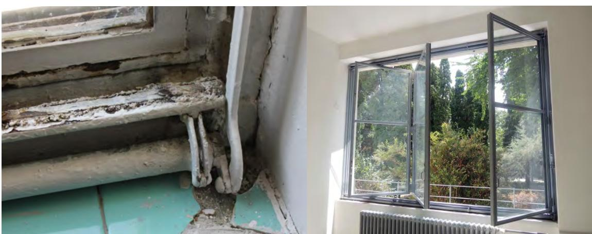
**Obr. 5:** Veľkorozmerné oceľové okno so zdvojeným zasklením a dotláčacím mechanizmom otvárania, pokročilá korózia a mnohovrstvové sekundárne nátery, vľavo stav pred reštaurovaním, vpravo sfunkčnené otváranie okna po reštaurovaní.
