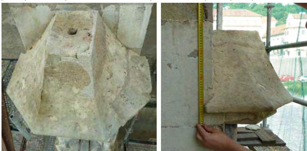
**Obr. 2:** Podrobné zameranie a dokumentácia pôvodných pieskovcových hlavíc z 19. storočia na lešení in-situ.
