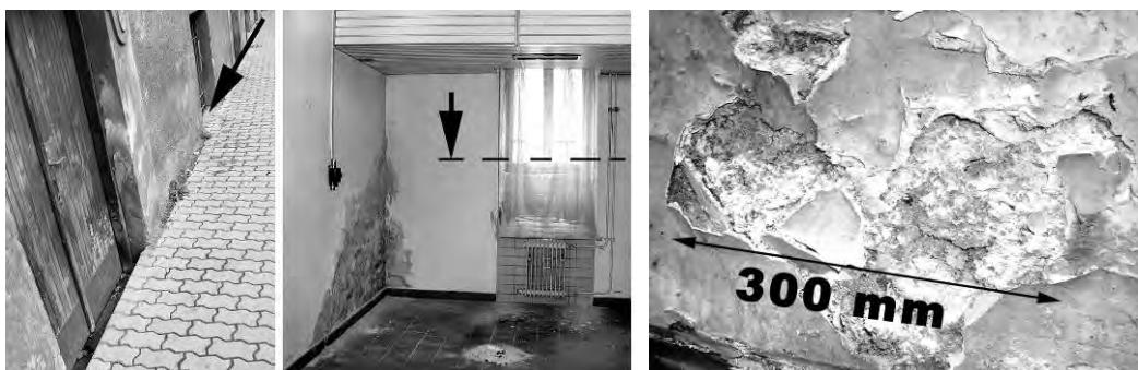
**Obr.2:** Vľavo: Secesná budova bývalej reálnej školy, Žilina. Typická ukážka prejavov porúch, vzniknutých zvýšenou niveletou terénu a posypovými soľami v kombinácii s nefunkčnou/neexistujúcou izoláciou. Poruchy sú zvýraznené keramickým obkladom stien, realizovaným v snahe eliminovať vlhkosť a pleseň. Vpravo: rozsiahle výkvety solí s pomerne veľkým objemom poškodenia. Foto: Z. Grúňová, 2014.
