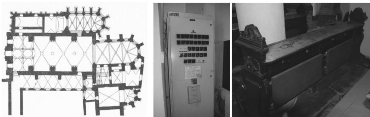
**Obr.7:** 7a) Pôdorys Františkánskeho kostola Zvestovania Pána, 7b) Ovládanie osvetlenia a vykurovania v sakristii, 7c) sálavé vykurovacie telesá v laviciach hlavnej lode.
