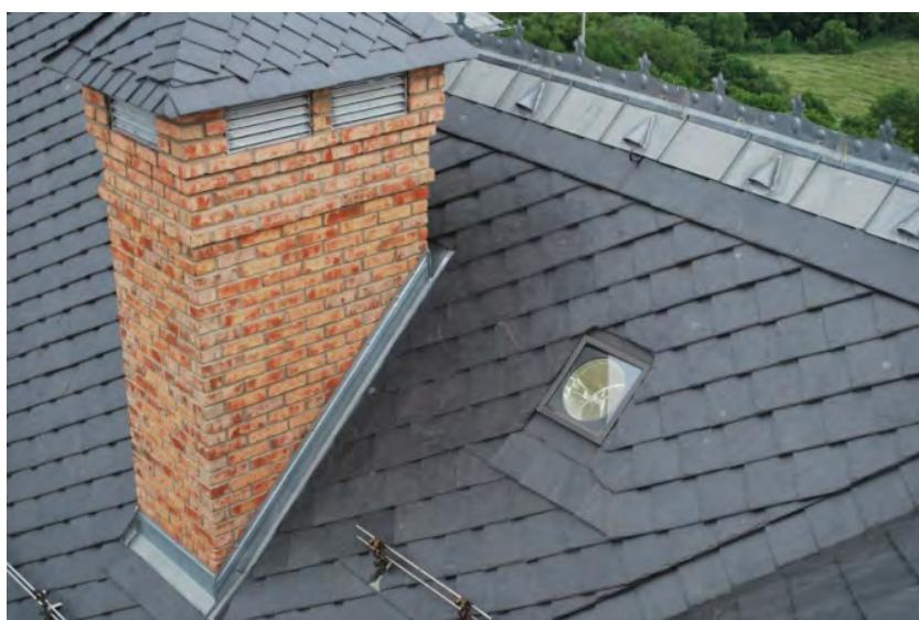
**Obr.8:** Detail svetlometu, dôsledok zmeny využitia podkrovia a uloženia vzduchotechniky,
