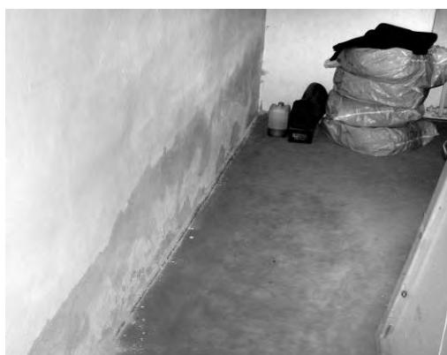
**Obr.3:** Podobný mechanizmus poruchy na kaštieli v Brodzanoch – vysoká niveleta terénu v exteriéri, zhoršený nevhodným riešením drenáže. Foto: J. Babjak, 2014.
