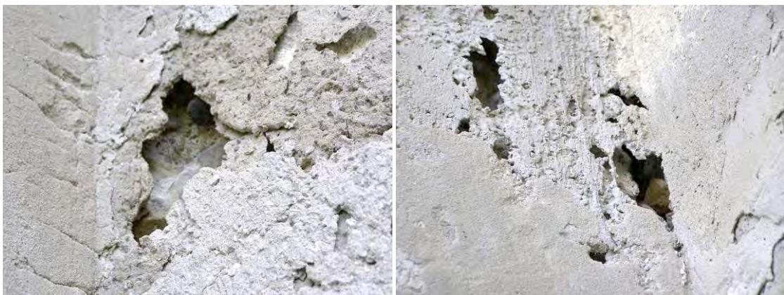
**Obr.7:** Kaštieľ v Brodzanoch. Spodné vrstvy omietok sú v niektorých miestach v podstate vyplavené, ostala zachovaná len povrchová vrstva cementového nástreku. Foto: J. Babjak, 2014.
