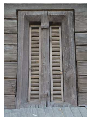
Obr. 25: Nové vetracie otvory z vonkajšej časti kostola na východnej strane, detail otvoru.
