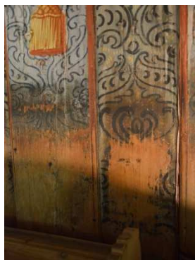
Obr. 18: Poškodenie maliarskej výzdoby na doskovom obložení vplyvom zavlhávanie a zatekania z minulosti – v niektorých miestach došlo k úplnému vymytiu farebnej vrstvy.
