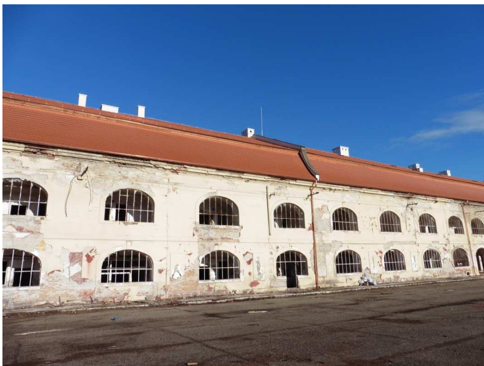
Obr. 8: Pohľad na obnovenú strešnú konštrukciu mestského pravého krídla v roku 2015, autor: Tóth, I.
