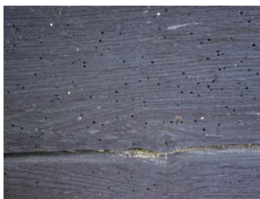
Obr. 20: Výletové otvory drevokazného hmyzu v trámoch zrubu severnej steny (exteriér) aj s požerkami.
