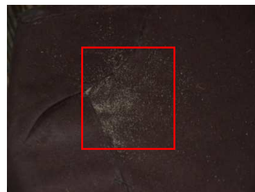
Obr. 10: Požerky po drevokaznom hmyze na lavici na empore.
