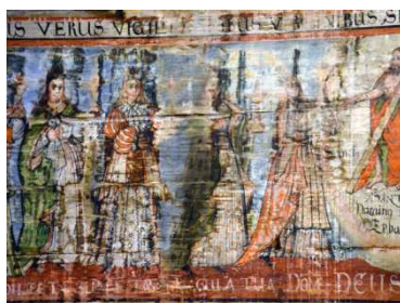
Obr. 5: Degradácia farebnej vrstvy na nástenných drevených maľbách vplyvom zavíhania.
