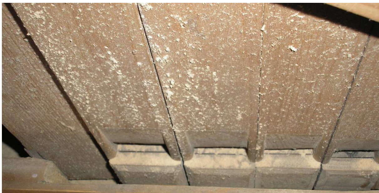
Obr. 2 Drevený píšťalový fond poškodený drevokazným hmyzom
