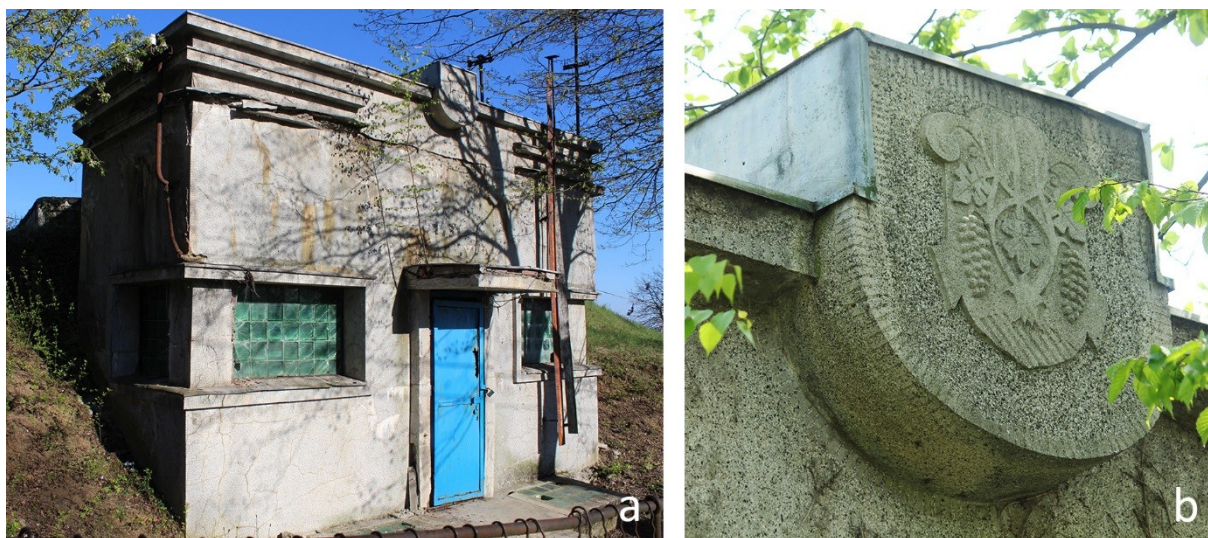
Obr.5: Súčasný stav budovy vodojemu: a) celkový pohľad; b) prvok fasády s erbom Užhorodu. (Foto: Lina Dehtáreva)
