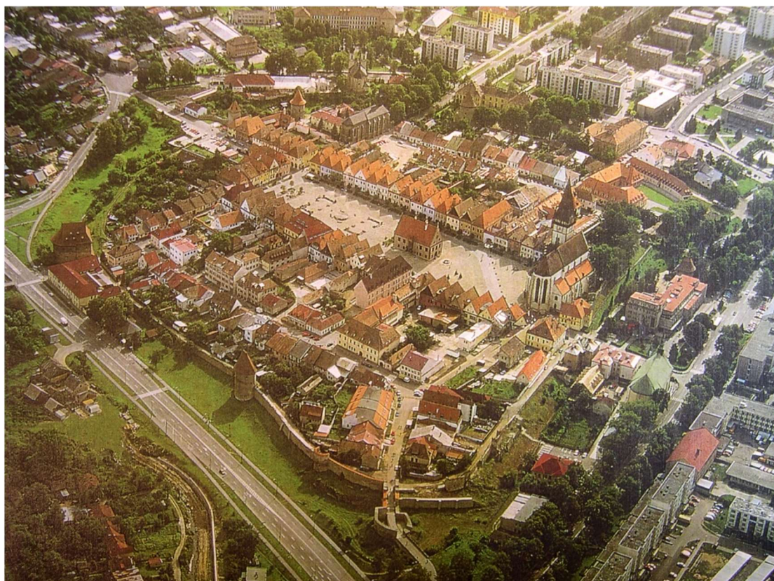
Obr. 5: Letecký pohľad na pamiatkovú rezerváciu Bardejov z roku 2001
