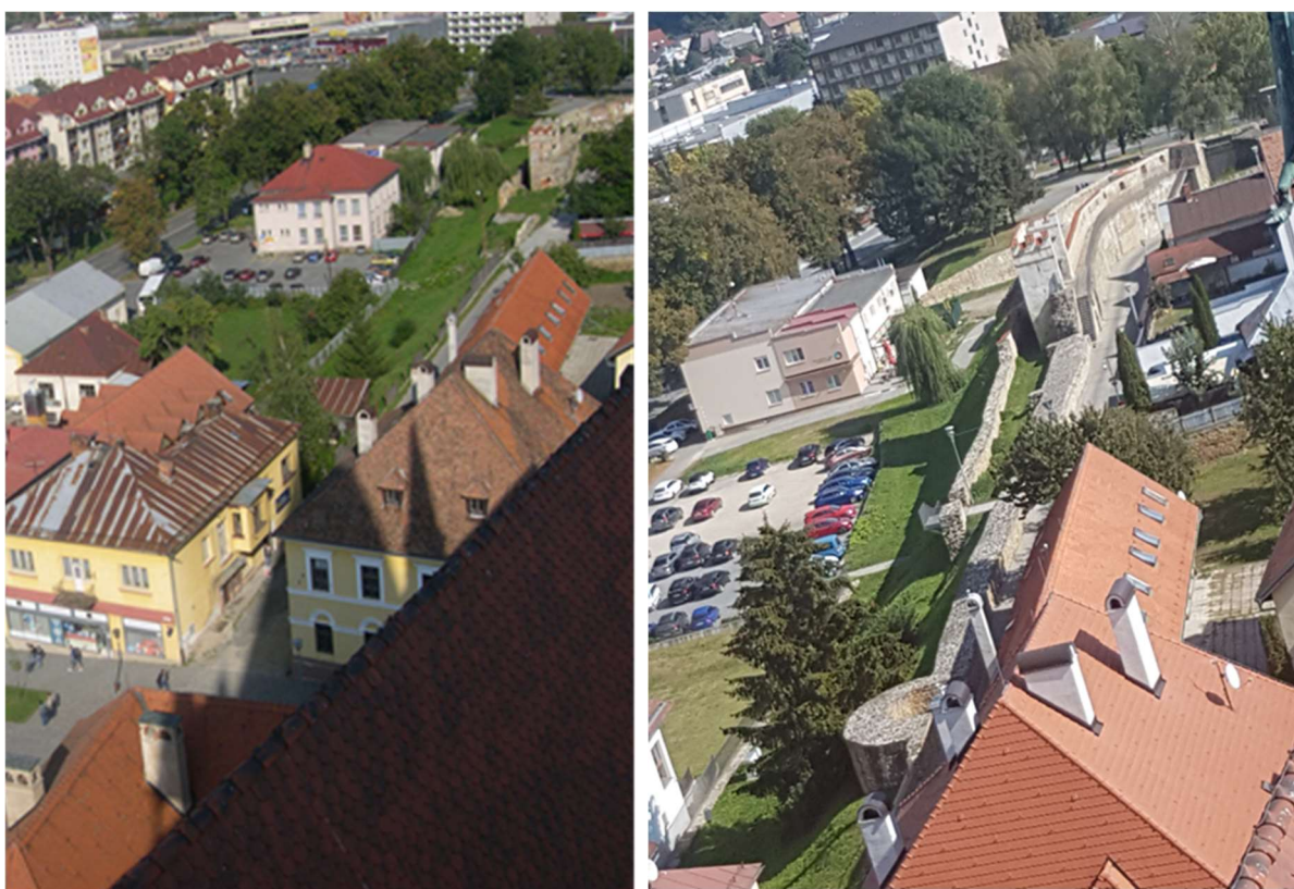
Obr.13: Severná časť opevnenia pred rekonštrukciou. Zdroj: Krajský pamiatkový úrad Prešov
