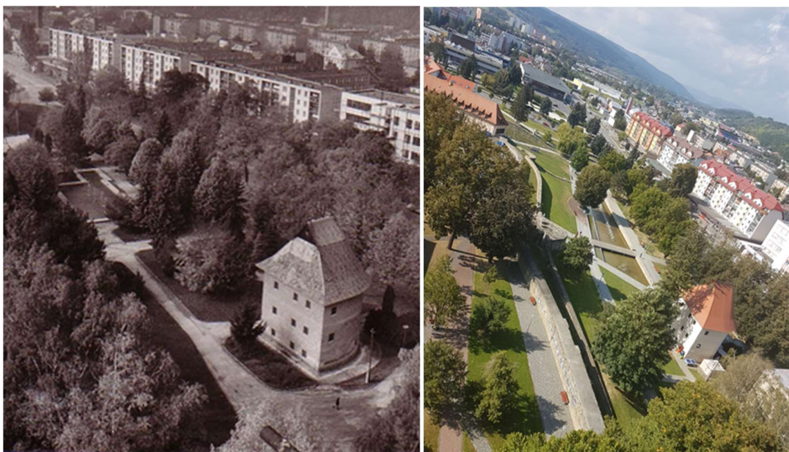
Obr.15: Severná časť opevnenia pred rekonštrukciou. Zdroj: Krajský pamiatkový úrad Prešov
