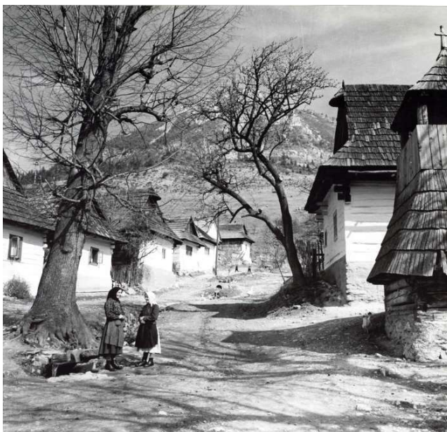
Obr.1 Vlkolínec pred vyhlásením za pamiatkovú rezerváciu ľudovej architektúry (zdroj: www.vlkolinec.sk )
