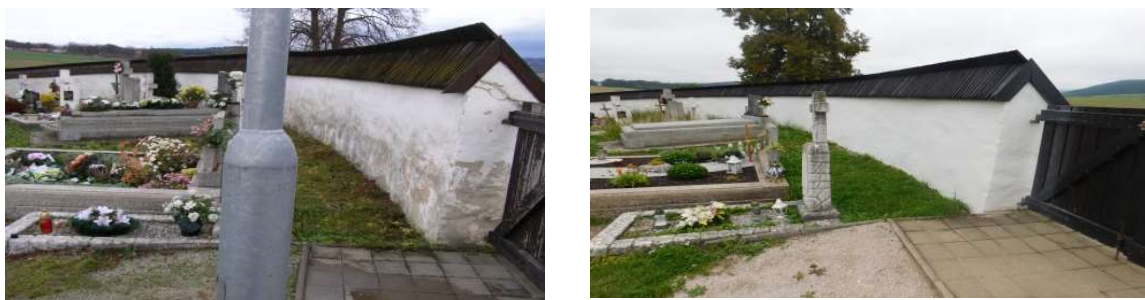
Obr.2: Východná časť ohradného múra kostola sv. Ducha v Žehre. Na obrázku vľavo stav pred obnovou, na obrázku vpravo stav po obnove v r. 2019.
