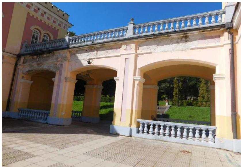
Obr. 3: Aktuálny stav zdegradovaných omietok vnútornej strany átria v kaštieli v Hodkovciach.
