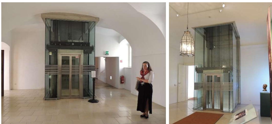
Obr.3) Teleso výťahu na prízemí zámku, prestup cez klenbu do 2NP b) Teleso výťahu na 2NP. Realizácia z prvej fázy obnovy. Poloha bola určená logicky pri nástupnom schodišti do celej miestnosti, čím sa dosiahlo potrebné veľkorysé predpolie a zostalo celistvé vnímanie priestoru. Foto T.Varga, 08/2020.
