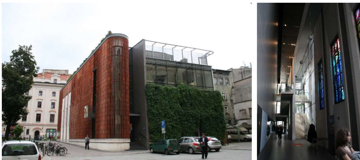
Obr. 21., 22. V exteriéri homogenizuje rôznorodé prostredie, v interiéri ponúka bohatosť vnemov.
