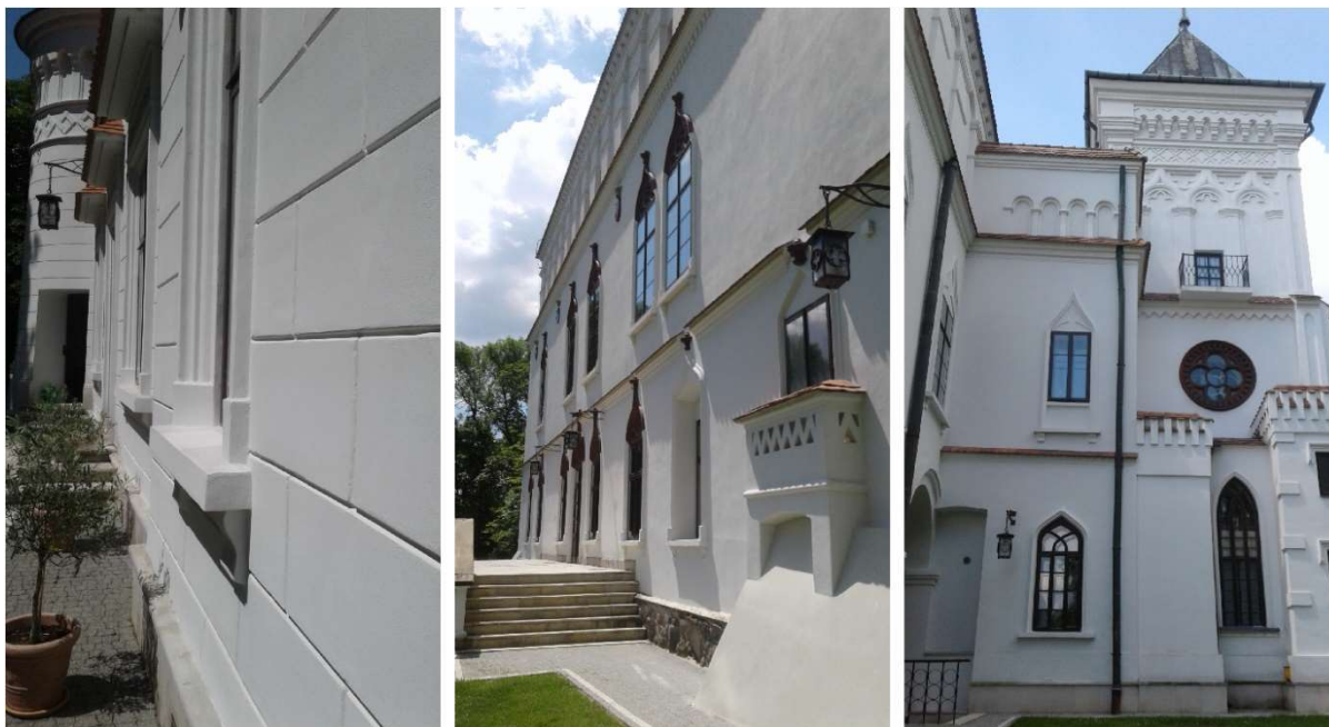
Obr.5: Prvky budovy, ktoré sú viditeľne v dobrom technickom stave. Stanisław Leś, Krystian Sikorski
