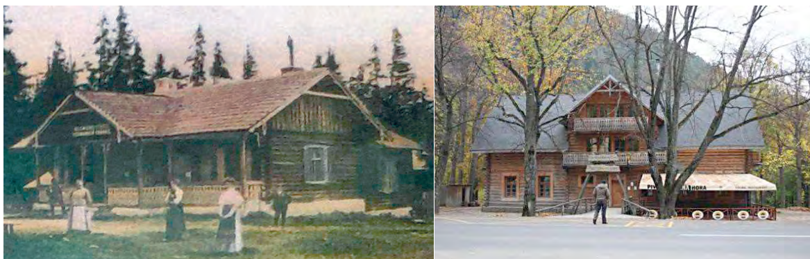
Obr. 10, 11: Drevená zrubová budova bývalého hostinca v osade Kežmarské Žľaby na dobovej pohľadnici (vľavo), vpravo foto zrubového hostinca v osade Tatranská Kotlina. Zdroj: [17]+ autorka
