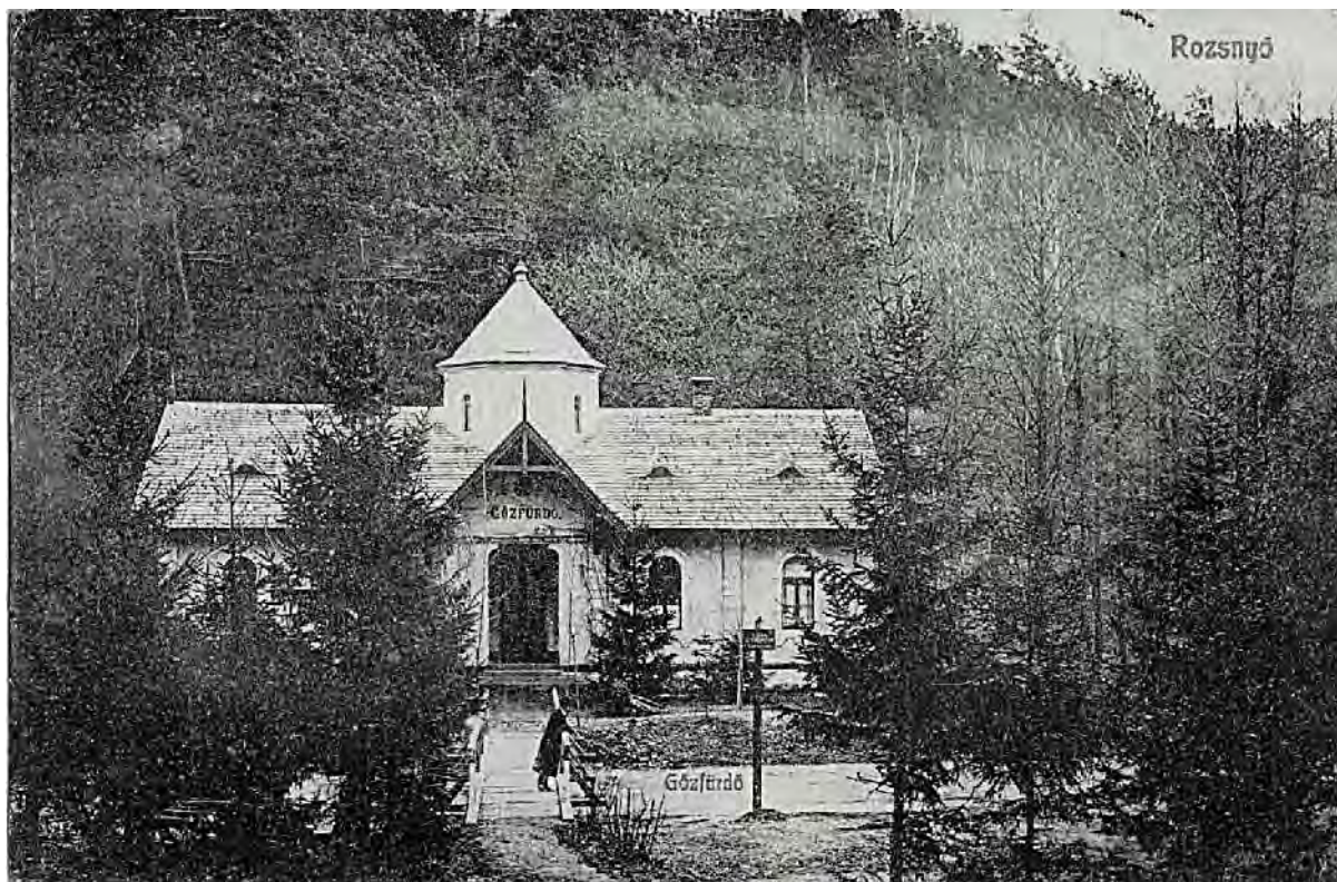
Obr.4: Kúpeľná budova – parný kúpeľ (prelom 19. a 20. storočia) Zdroj: Archív KPÚ Košice, pracovisko Rožňava
