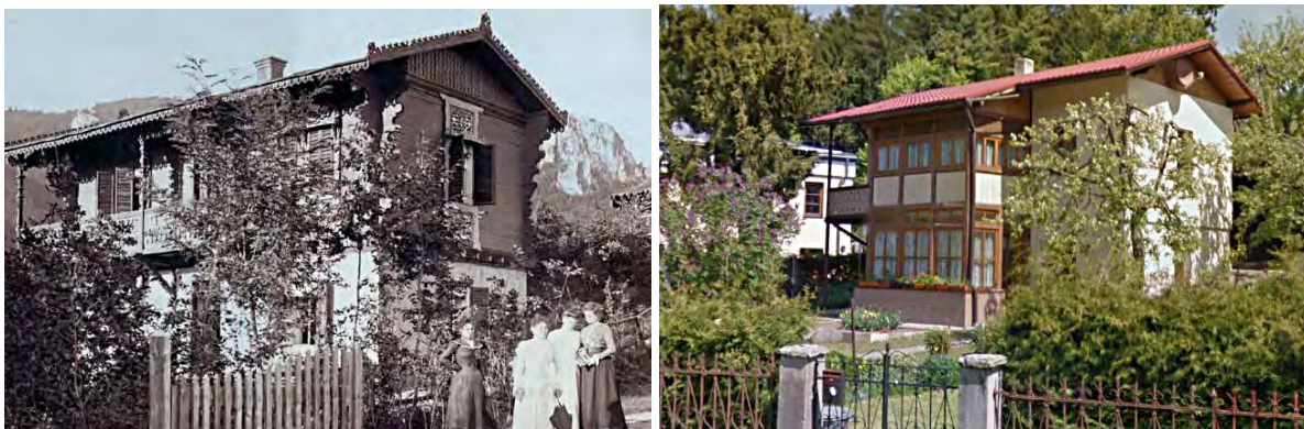
Obr.10: Villa Tulipán na dobovej fotografii zo zač. 20. storočia a stavba, ktorá môže mať v sebe zachovaný zvyšok murovanej časti 1. n.p.. Archív a foto Grúňová, 2014.
