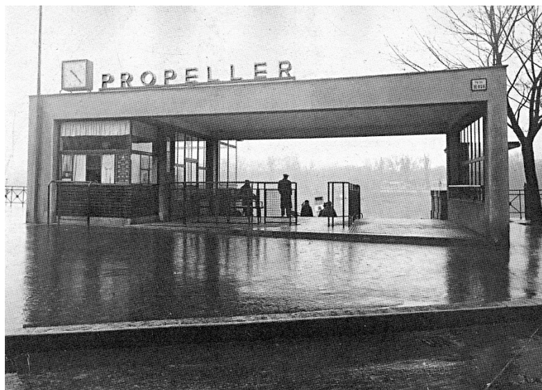
Obr. 5: Budova nástupištia propeleru na mestskej strane od architekta Emila Belluša z roku 1930. [6]
