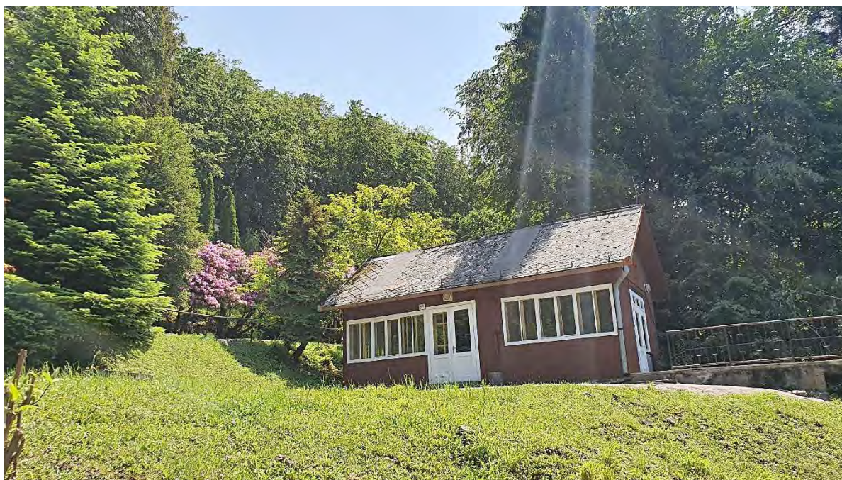
Budova kolkárne neďaleko vstupu do parku
