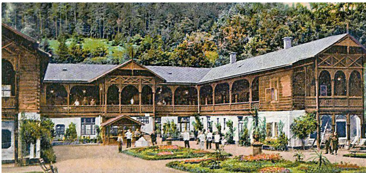
Obr. 12: Zaniknutý kúpeľný dom v kúpeľoch Brusno bol postavený kombináciou murovanej technológie napríklad s drevenou nadstavbou poschodia. Zdroj: [21]
