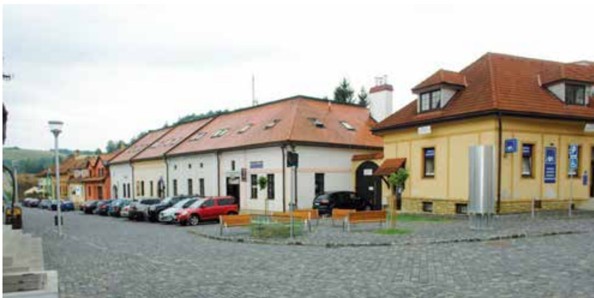
Stöcklova ulica po rekonštrukcii
